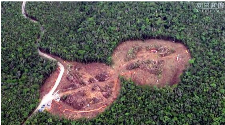
樹木が伐採された米軍北部訓練場のヘリパッド工事現場
